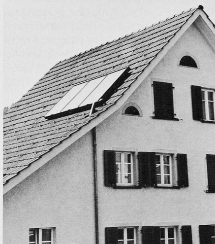
Bild 1. Der 5 m 2 grosse Kollektor mit der noch etwas unschönen Verbindung zum Regenfallrohr, in dem Vor- und Rücklauf liegen
