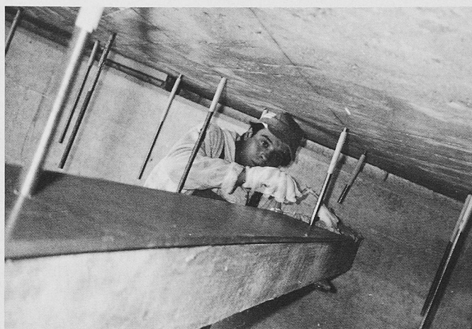
Bild 8. Aufbringen des Klebers auf die Lamellen
