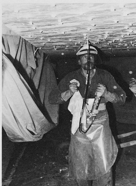
Bild 6. Injektion der Risse in den Nachtstunden
