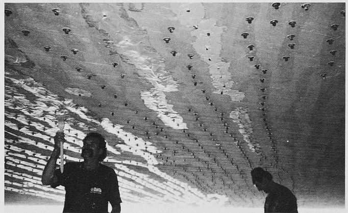
Bild 5. Abdichten der Risse für die Injektion
