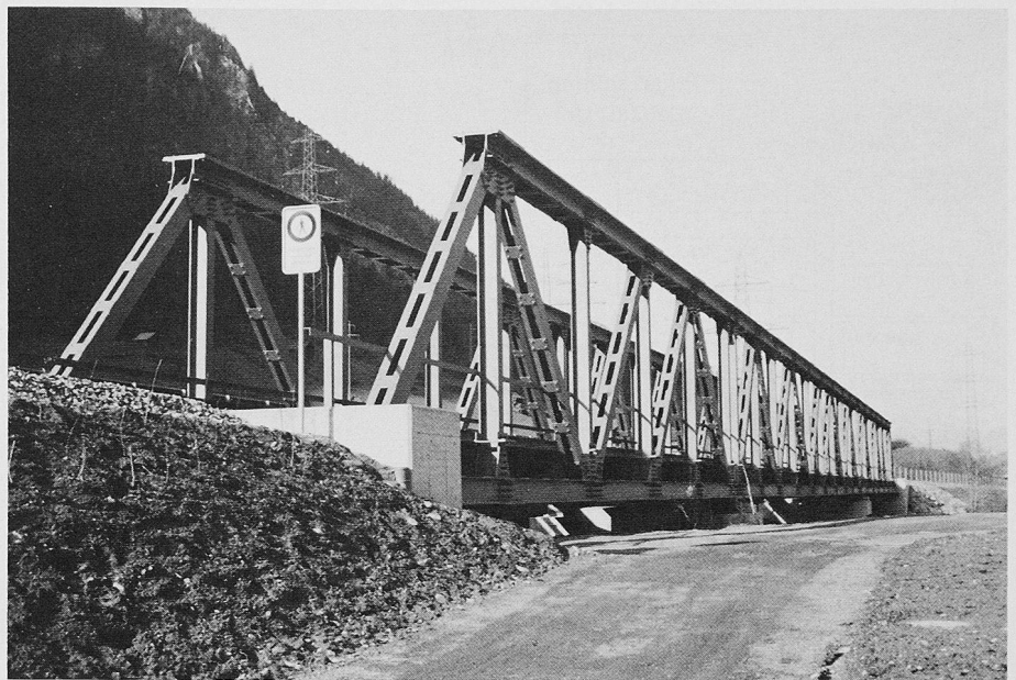
Bild 7. Brücke Silenen, Modell SKR, Blick flussabwärts
