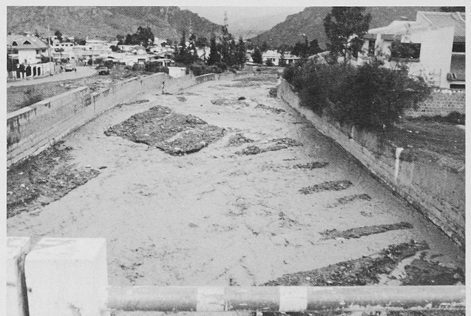
Bild 2. Bei beidseitig vorhandenen Mauern teilt sich der Fluss aufgrund der Strömungsverhältnisse. Es können sich in der Mitte Inseln bilden
