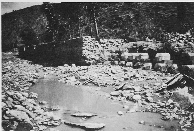
Bild 13. Der Zustand am 12. Oktober 1988
