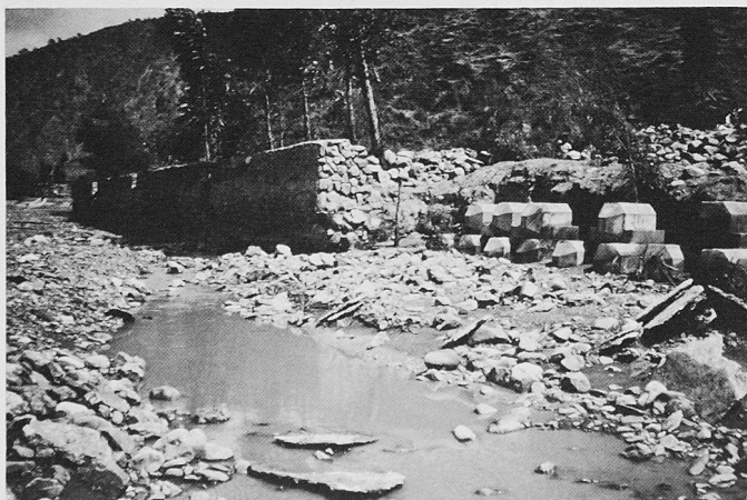
Bild 13. Der Zustand am 12. Oktober 1988
