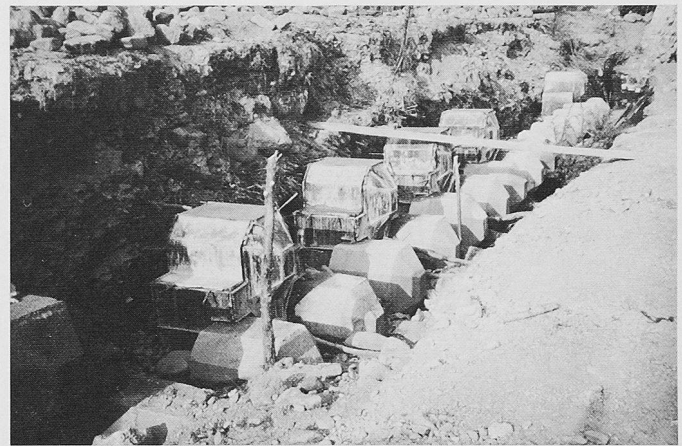
Bild 11. Metallschalungen und fertige Blöcke
