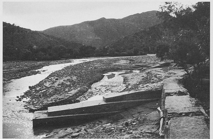
Bild 7. Auskolkung an einer Buhne (Bild: E. Decormis, Sucre)
