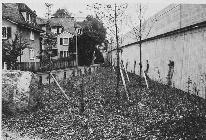
Bild 6. Die Überdeckung ausserhalb des Stützmauerbereichs, Ginsterweg (Mai 1993, Foto M. Frick)
