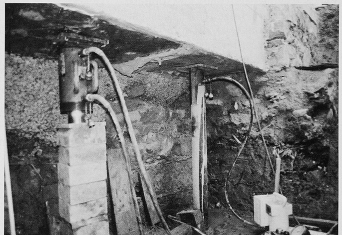
Bild 6. Press- und Injektionsbohrpfähle, Objekt Kirche Teufen
