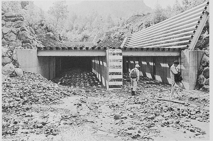
Bild 12. Murgangbremse beim Kamikamihorizawa am Mount Yakedake
