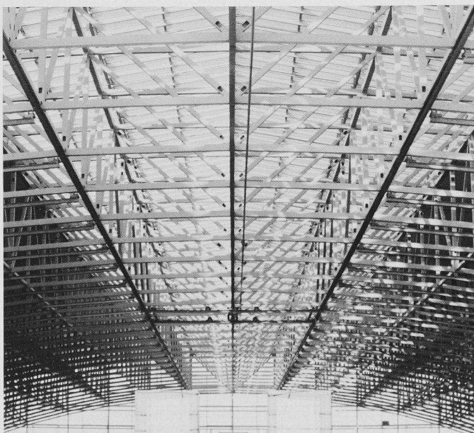
Bild 1. Frankfurt: 2400 t feuerverzinkter Stahl für die Dachkonstruktion
