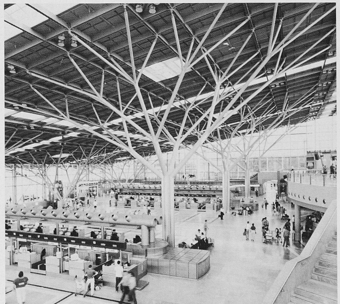
Bild 2. Stuttgart: filigrane Baumstützen aus Rundrohr im Flughafenterminal
