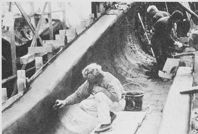
Bau der Olympia-Bobbahn in Lillehammer: Bearbeitung der Betonoberfläche
