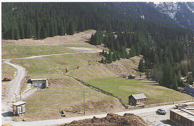
Bild 10. Selfranga kurz vor Baubeginn. Unten links die NO x -Messstation im Mannschaftswagen der Gemeinde Klosters-Serneus (Photo: Photostudio Oberli, Klosters)
