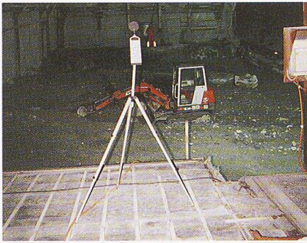
Bild 14. Lärmmessung der Lüftung des Zugwaldtunnels um Mitternacht (Photo: I. Sommer, BfÖ)
