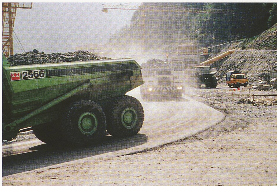
Bild 1. Staub auf der Baustelle Sagliains (Photo: I. Sommer, BfÖ)
