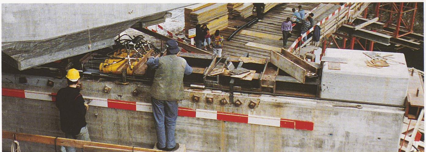
Bild 4. Querverschubbahn Seite Davos mit Abstütznocken, Füllelementen, Pressenbatterie und Führungswinkeln; aktuelle Verschubdistanz 3,6 m (Foto: Zschokke)
