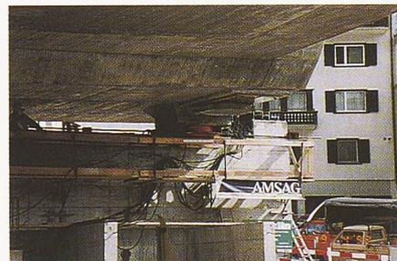
Bild 2. Abstützung des Brückenträgers über das rote Taktshublager auf den Querverschubträger (Foto: F. Gruber)
