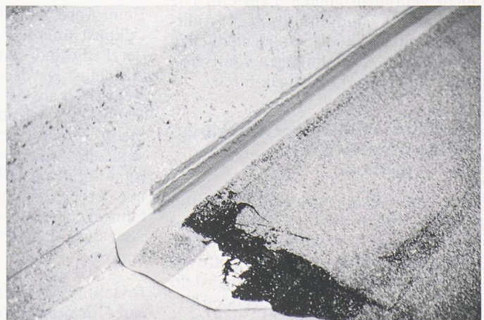
Bild 5. Anschluss 4: Das PVC-Fugenband ist mit Epoximörtel an der Betonwand befestigt und durch Polymerbitumen mit der PBD verbunden
