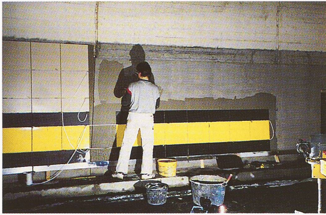
Bild 10. Aufziehen der Feinsteinzeugplatten
