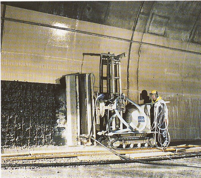
Bild 5. Hydrodynamischer Betonabtrag beim Ausbautyp A
