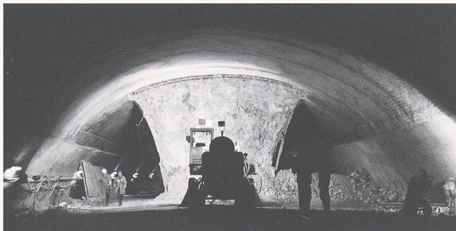
Bild 6. Kalottenvortrieb in der Verzweigung
