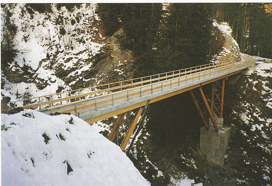
Ansicht der fertigen Ronatobelbrücke
