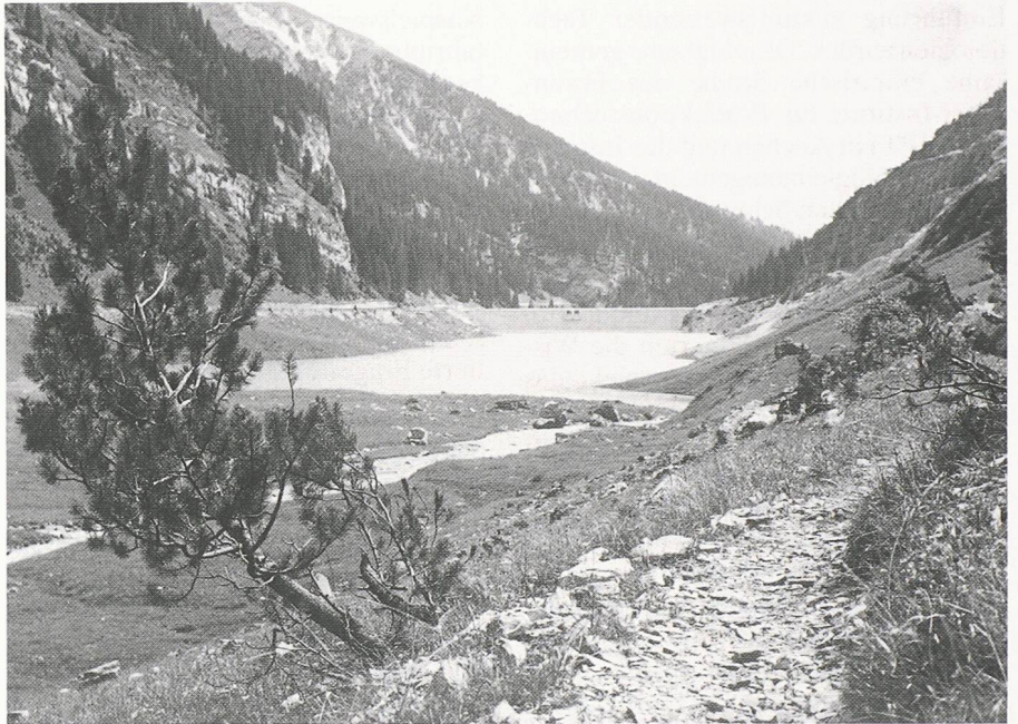
Der neue Stausee auf der Bündner Alp Panix begann im letzten Sommer, sich zu füllen. Die Wasserkraft wird für das Kraftwerk Ilanz 2 genutzt (Bild: Comet)
