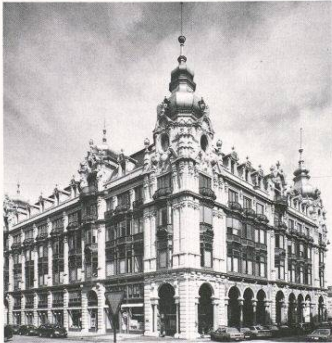
Die Stadt Zürich erhielt von der Pro Renova das «Goldene Dach» als Auszeichnung für die vorbildliche Renovation des Geschäftshauses «Metropol»
