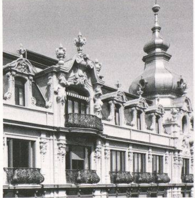
Die ursprünglichen Gussgeländer der Balkone wurden anhand von Fotografien aus der Jahrhundertwende in Aluguss rekonstruiert
