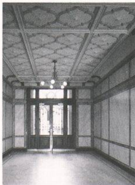
In den seitlichen Eingängen wurden die Marmorierungen an den Wänden erneuert, eine für damalige Zeit typische Bemalung (Bilder: A. Melchior, Uitikon-Waldegg)
