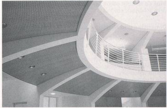
Die gewölbten Deckenelemente, die aus akustischen Gründen gelocht sind, konnten kostengünstig auf einem CNC-gesteuerten Bearbeitungszentrum realisiert werden (H. Herger, Altdorf)
