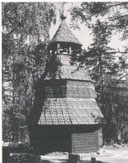
Die materialtechnischen Gegebenheiten des Holzes wurden hier dekorativ umgesetzt (achteckiger Glockenturm von Ruokolahti in Finnland, um 1750)
