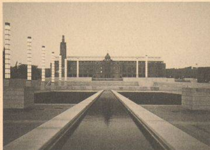
Wichtiger Punkt während der Olympiade 92 in Barcelona: das mit «Sulzer Infra-Klima» ausgestattete Radio- und Fernsehübertragungszentrum
