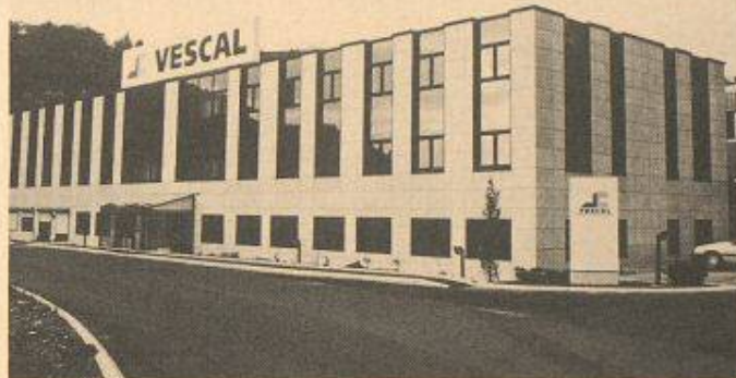
Das neue Verwaltungsgebäude der Vescal AG in Vevey/St-Légier
