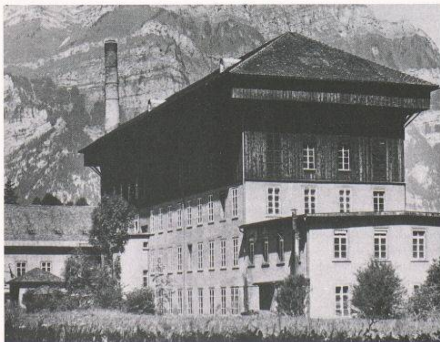
Der grösste Hänggiturm der Schweiz, erbaut 1865, auf dem Areal der Forbo Alpina AG in Ennenda vor dem Abbruch (Bild: Hans Aebi)
