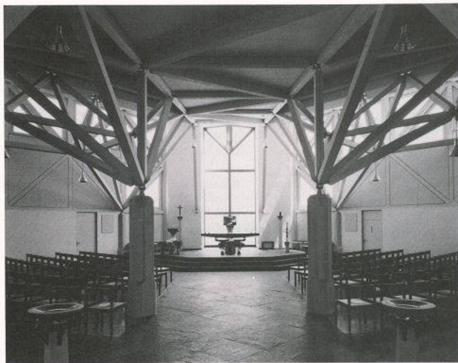
Bild 3. Holzraumfachwerk (Übersicht)
