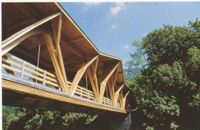
Bild 7. Die dem Wetter ausgesetzten Teile der Konstruktion sind mit einer Lärchenschalung oder mit Bleck abgedeckt. Der äussere Teil des zweiteiligen Untergurtes ist ausserdem druckimprägniert
