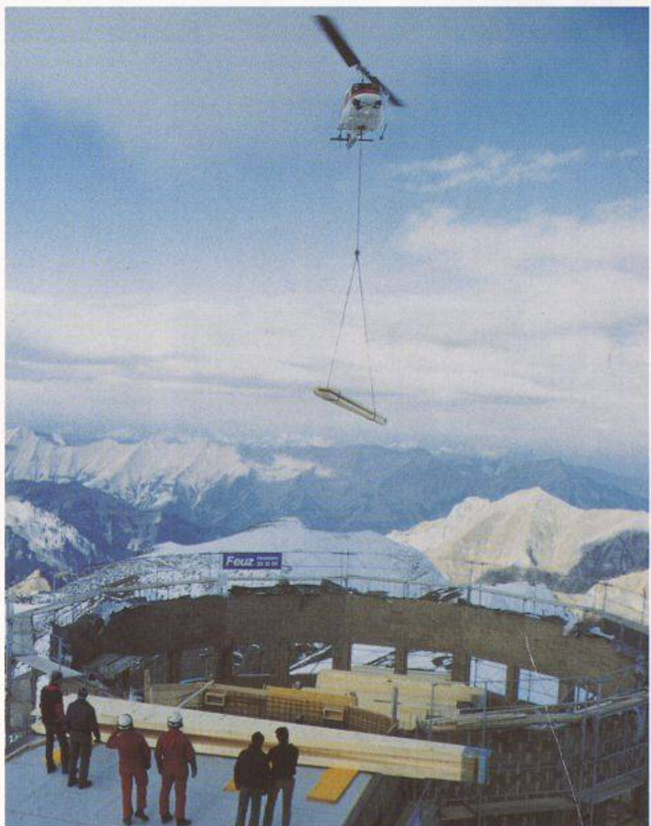
Bild 1. Deckenkonstruktion Touristorama Schilthorn, unsere höchste Baustelle mit entsprechenden Transportmitteln
