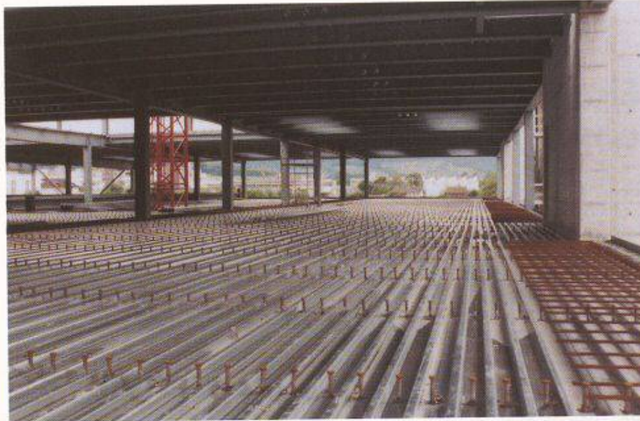
Bild 4. Zwischengeschossboden einer Haupthalle vor dem Betonieren
