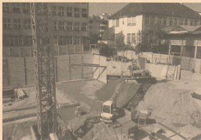
Einsatz des Verbausystems RRV bei einer Baugrube für ein Geschäftshaus mit zwei Untergeschossen in Zürich-Altstetten
