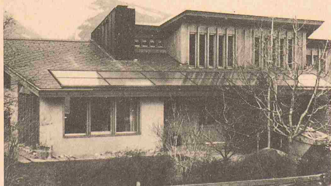
Ins Dach integrierte Sonnenkollektoren bei einem Gebäude in Aesch bei Spiez
