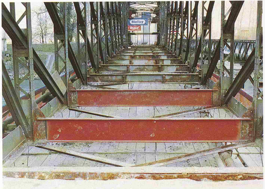
Bild 10. Die Brücke vor dem Sandstrahlen und Anstrich
