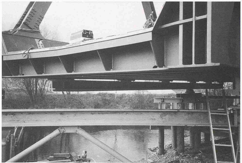
Bild 6. Endknoten am Auflager, Perspektive
