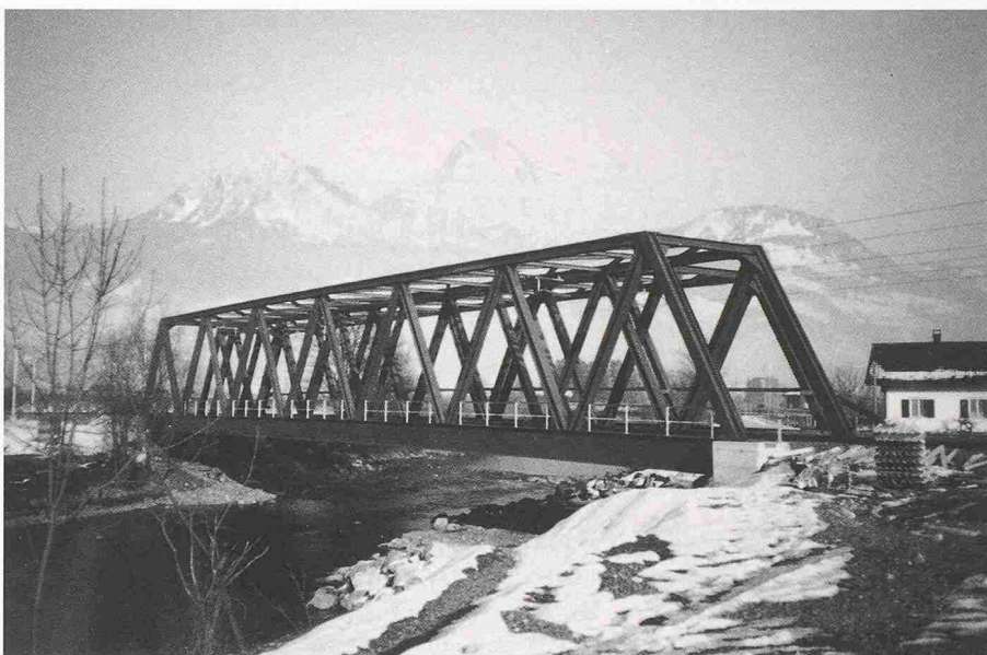
Bild 1. Neue Muotabrücke, Übersicht
