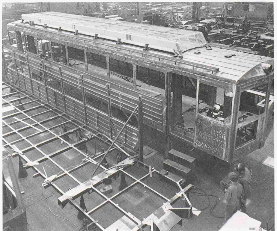
Rohkasten eines Triebwagens, im Vordergrund der Bodenrahmen eines Steuerwagens mit Seitenwand. Am unteren Bildrand in der Mitte der Kupplungstunnel mit Fachwerk.
