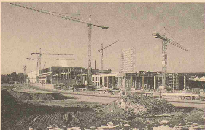
Wolff-Turmdrehkrane im Einsatz beim Bau der neuen Papierfabrikationshalle der Papierfabrik Biberist
