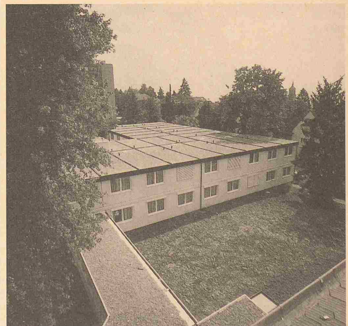
Das aus vorfabrizierten, mobilen Raumzellen zusammengefügte Klinikprovisorium während der Sanierung des Zürcher Bethanienspitals
