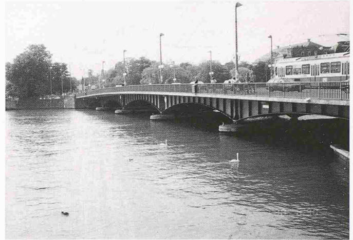
Bild 10. Quaibrücke, erbaut 1884, erneuert 1984
