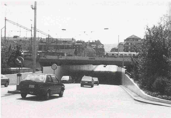
Bild 9. Militärbrücke, ehemalige schweisseiserne Hauptträger als Geländer verwendet, Spannbetonplatte als neue Tragkonstruktion
