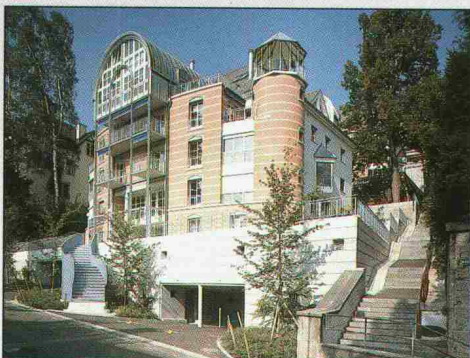
Mehrfamilienwohnbaus, St. Gallen Planung: Müller + Bamert, dipl. Arch. SIA/ETH, 9000 St. Gallen Ausführung der Spenglerarbeiten: Domeisen AG, 9016 St. Gallen
