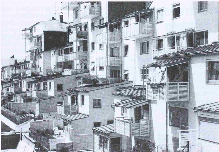
Bild 16. Einfache, glatte Baukörper werden durch angehängte Balkone, Laubengänge und aussenliegende Treppen individuell gestaltet
