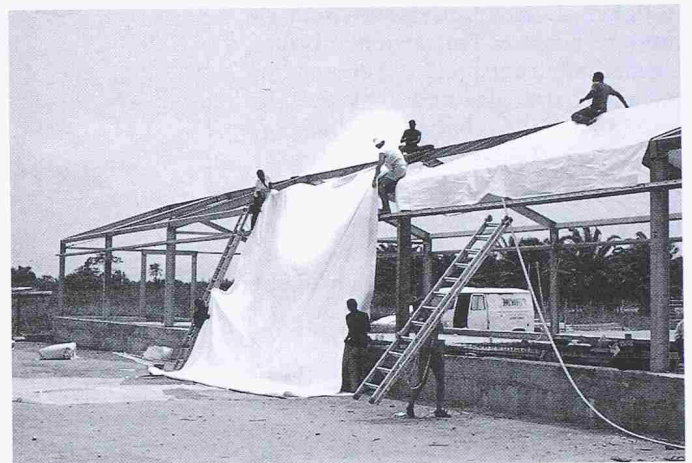
Bild 4. Montage der PVC-Sarnafil-Membrane
