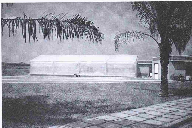
Bild 5. Hostafon-ET-Folien Gewächshaus (Ansicht)
