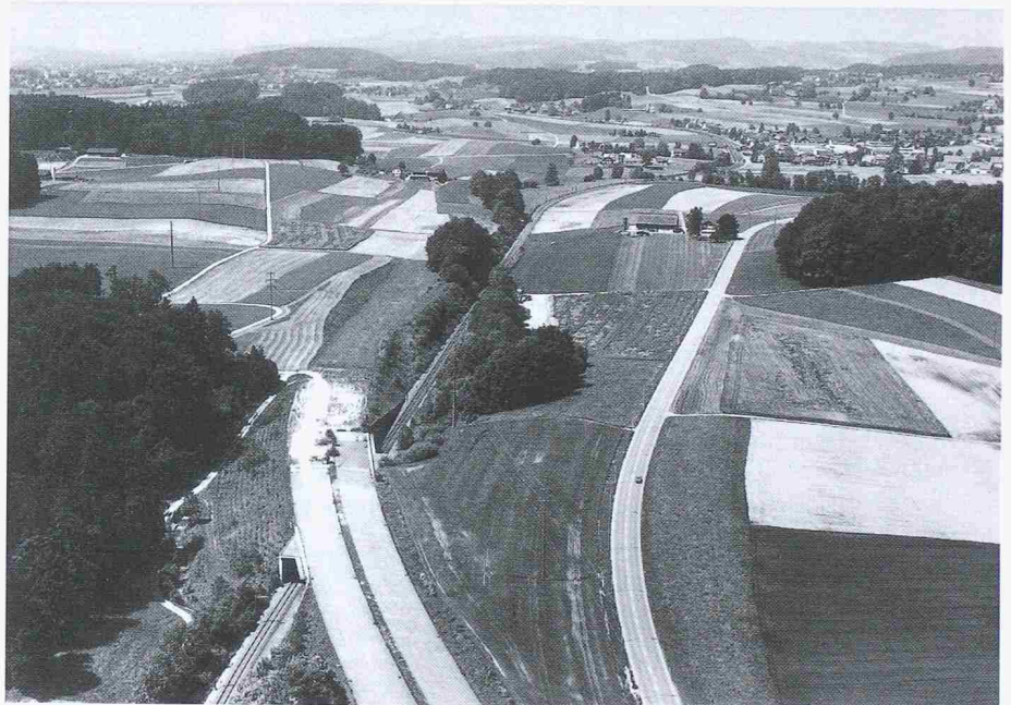
Im Knonauseramt wird die Inbetriebnahme des bereits erstellten N4-Teilstücks zwischen der Zuger Kantonsgrenze und Knonau vorbereitet. Flankierende Massnahmen gegen noch mehr Immissionen in den umliegenden Dörfern sind vorgesehen (Bild: Comet)
