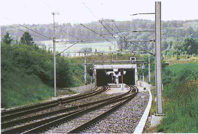
Bild 4. Portal Zürichbergtunnel/Station Stettbach
