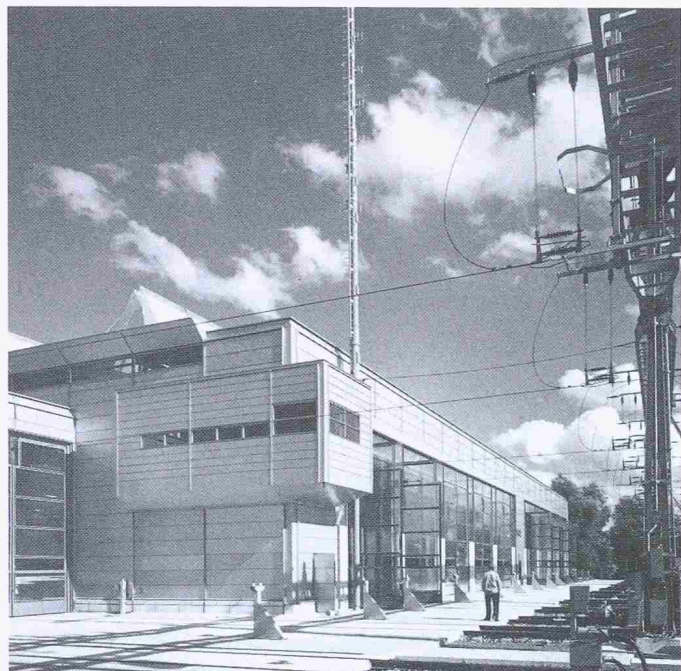
Bild 1. Torfassade mit Kommandoraum
