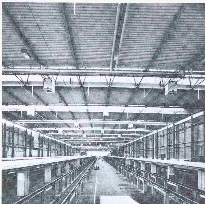
Bild 2. Innenansicht der grossen Halle
