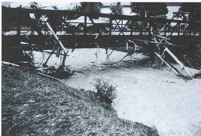
Bild 9. Brücke über die Alp nach dem Hochwasser 1984. Eine bergseitige Verschalung hätte hier das Hängenbleiben von Holz verhindert (Foto Baudepartement des Kt. Schwyz, Abt. Wasserbau)
