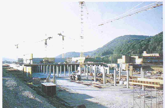
Bild 7. IKEA, Rohbau Blocklager
