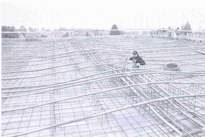
Bild 3. Vorspannbewehrung der Decken
