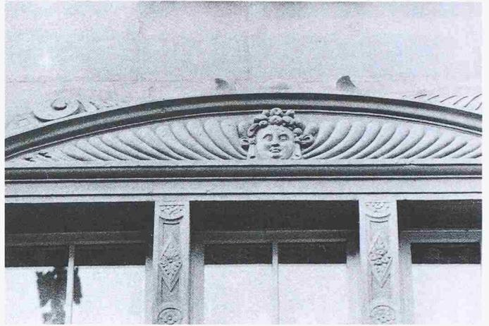
Bild 11. Bildhauerarbeit aus dem 16. Jahrhundert nach zurückhaltender Aufmörtelung
