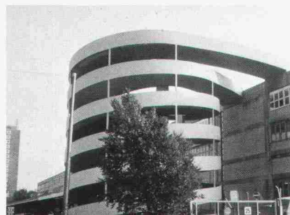
Rampe Parkhaus Migros Herdern
