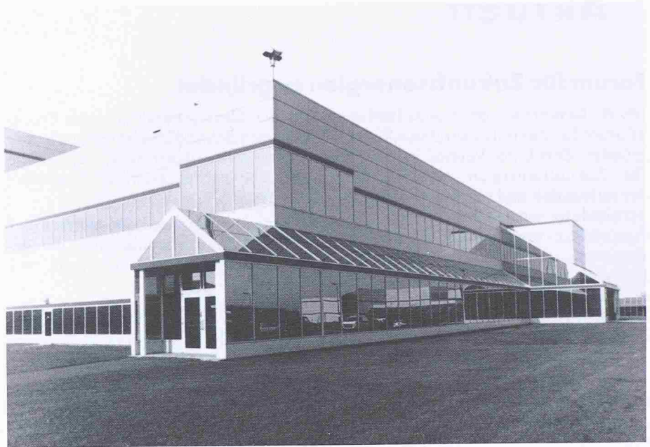
Im neuen IBM-Zentrum für Halbleitertechnologie werden programmierte Chips mit Hilfe der Röntgen-Lithographie entwickelt. Für die aussergewöhnlich aufwendigen Baumassnahmen war eine halbe Mia. Dollar nötig (Bild: IBM)
