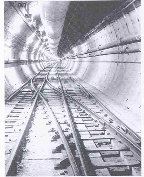
Bild 9. Blick in den Diensttunnel auf der britischen Seite (QA Photos)
