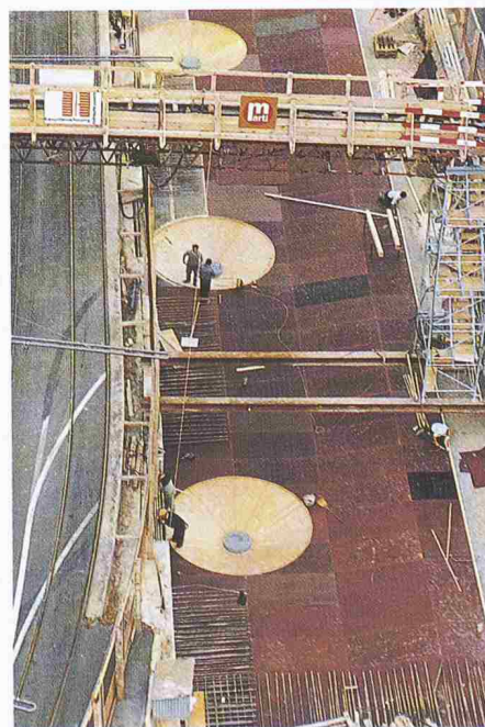
Bild 4. Decke über Fussgängergeschoss, Schalung
