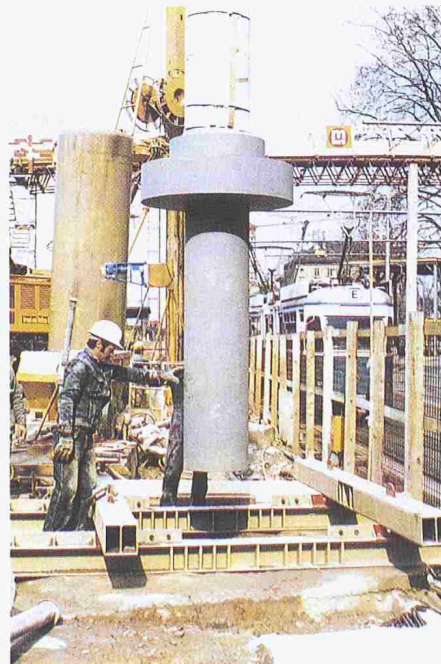
Bild 10. Verbinden der beiden Stützteile
