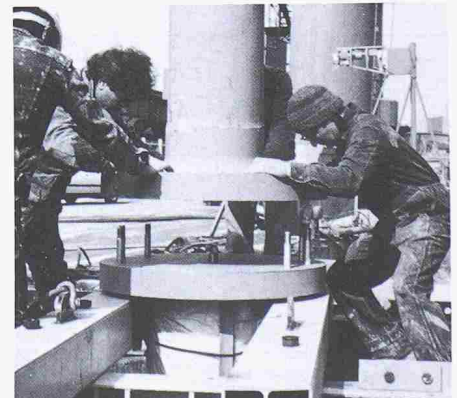
Bild 10. Verbinden der beiden Stützteile
