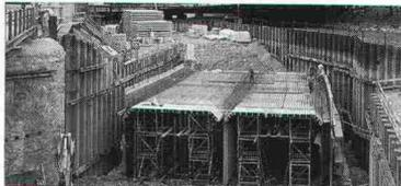
SZU-Bahnverlängerung im Sihlbett: Injektionsabdichtungen von Schwindrissen im ganzen Tunnel Selnau-Zürich HB.
