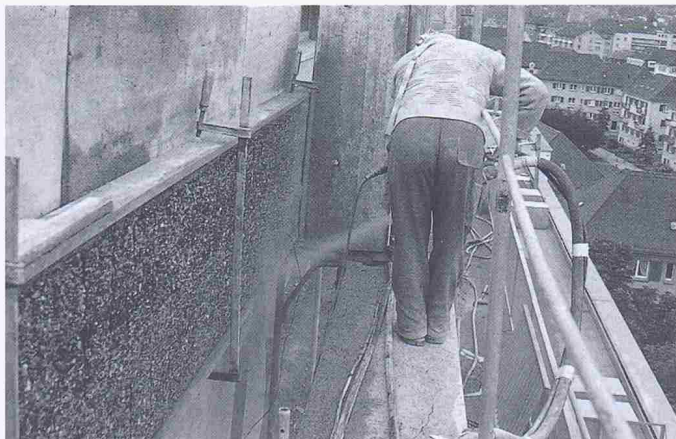
Bild 4. Applikation eines Besa-Spritzmörtels auf Microsilica-Basis (im Trockenspritzverfahren)
