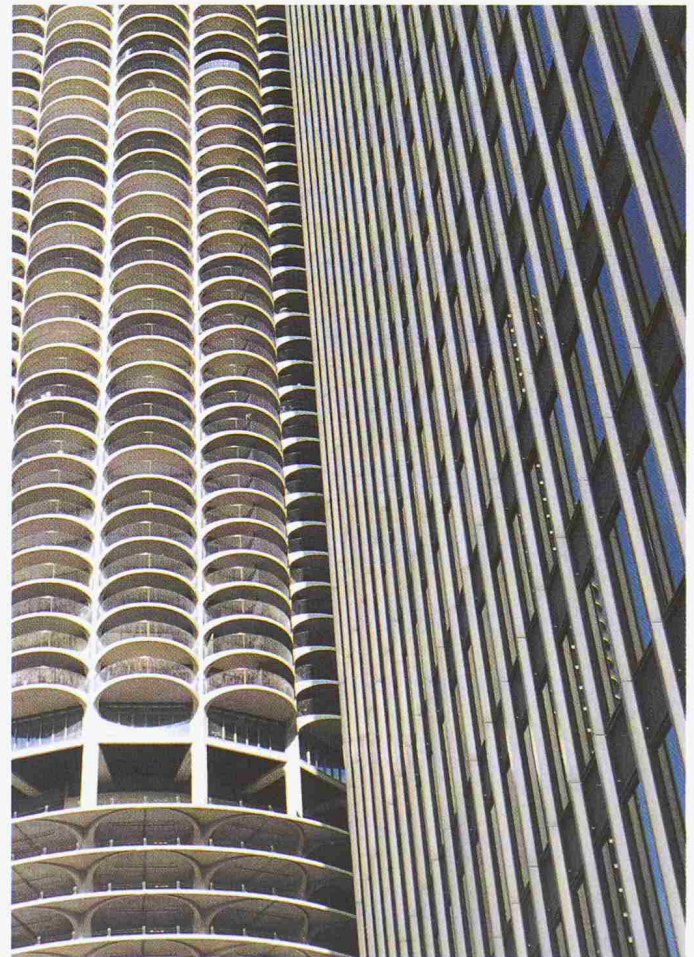
Kontraste, links die Fassadenstruktur der Marina Towers von Bertrand Goldberg, 1964
