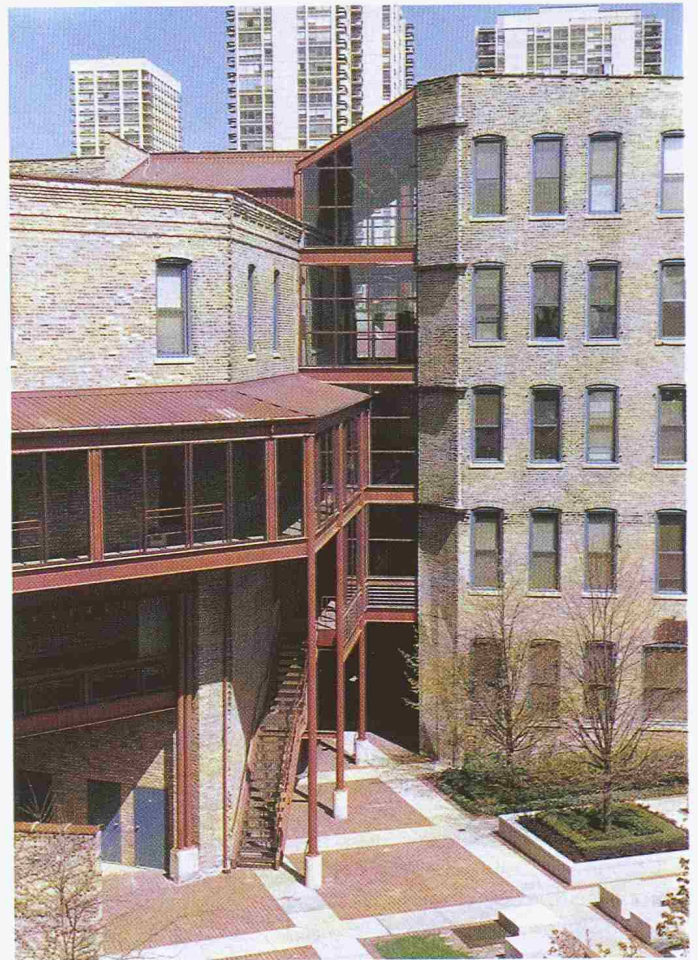
Cobble Square, Gallerien, Verbindungsbauten und Treppen in Stahl
