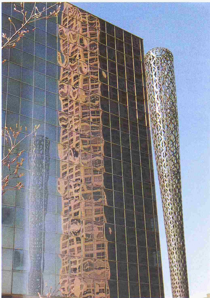
Spiegelungen, rechts eine 30 m hohe Stahlplastik beim Northwestern Terminal
