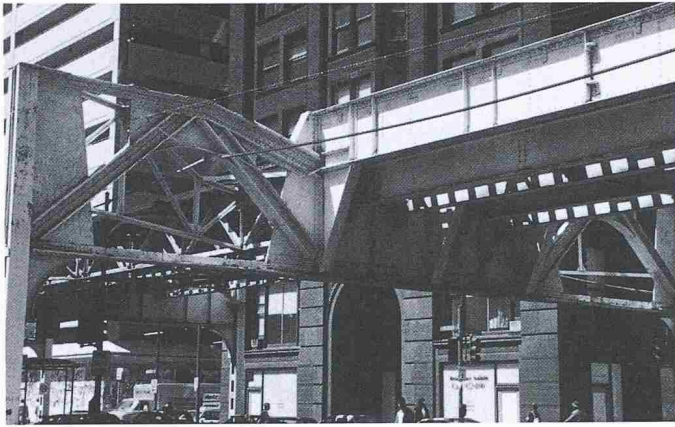
Die Unterkonstruktion der Hochbahn
