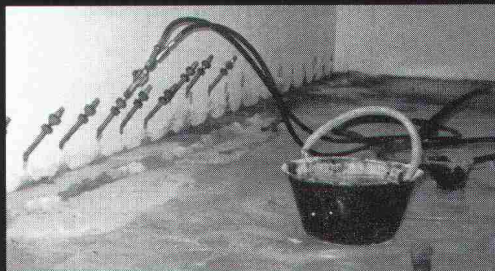
Elastische Abdichtungs-Injektion-Rascoflex in einer Zivilschutzanlage.
